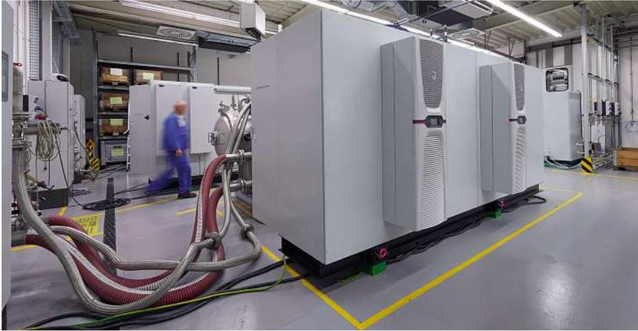
**Bild 3:** Um eine Temperatur von maximal 35 °C in den Schaltschränken zu erreichen, kommen zwei Kühlgeräte aus der neuen Serie Blue e+ von Rittal mit jeweils 6 kW Kühlleistung zum Einsatz.
