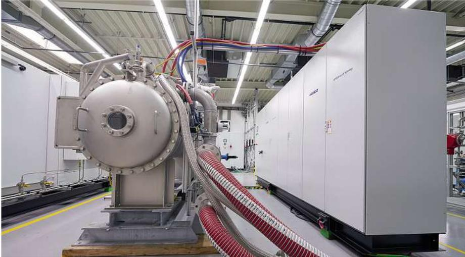
**Bild 2:** Die komplette Elektrotechnik ist in TS-8-Schaltschränken von Rittal untergebracht, die neben dem eigentlichen Ozonerzeuger installiert werden.
