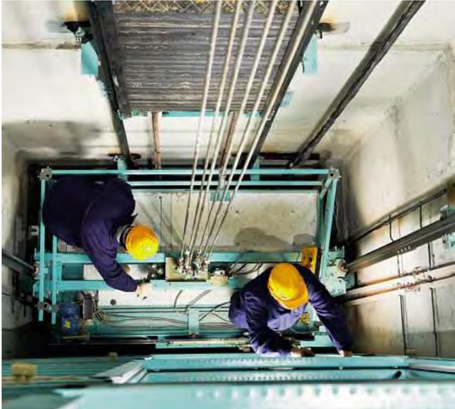
**Bild 1:** Auch in einer Wartungssituation soll es dem Wartungspersonal ermöglicht werden, mit geöffneter Fahrkorbtür zu fahren, um den Aufzugsschacht zu inspizieren. Dazu muss jedoch die Sicherheitstechnik abgeschaltet werden können. Das gelingt mit einer sogenannten Komfort-Steuerung.
