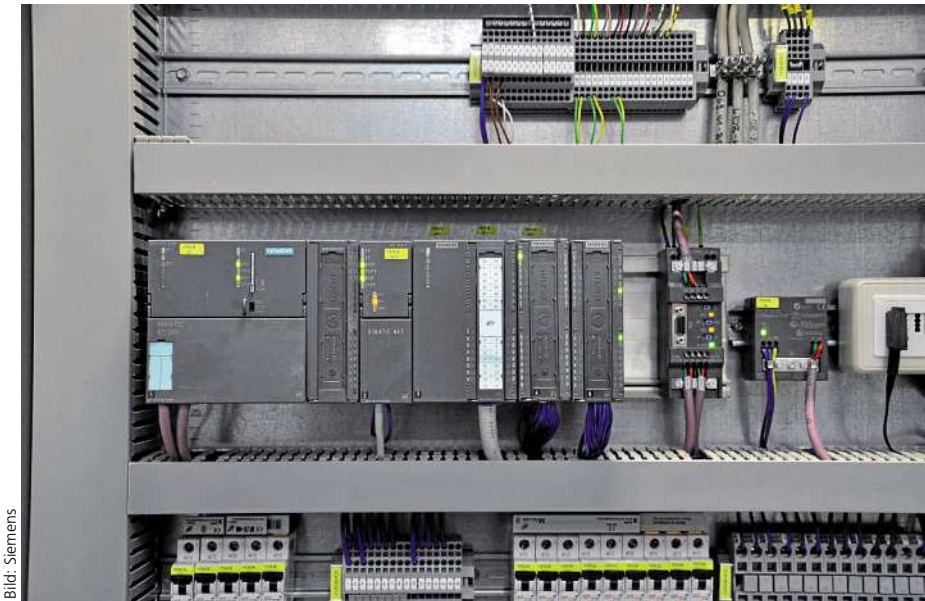
Bild 3: Die Simatic T-CPU dient zur flexiblen Koordination aller Abläufe.
