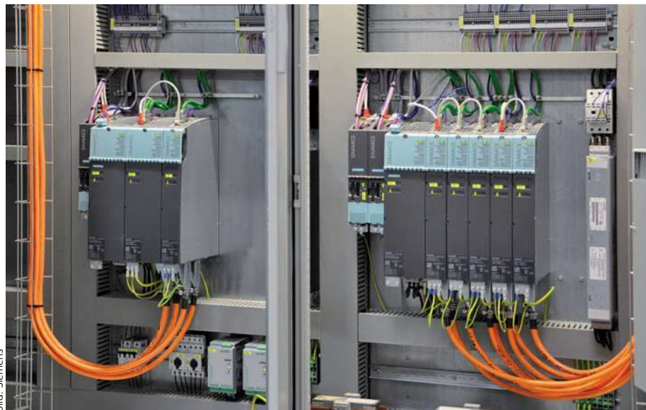
Bild 4: Das modulare Antriebssystem Sinamics S120 sorgt bei den Antrieben für Gleichlauf und präzise Produktionsgeschwindigkeit.
