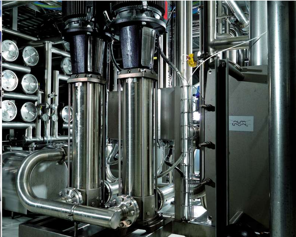
► Pumpen: Permanentmagnetmotoren zeichnen sich durch einen sehr hohen Motorwirkungsgrad aus. Der Motor benötigt für die Magnetisierung seines Rotors keine zusätzliche Energie, temperaturstabile Hochleistungsmagnete sorgen für die permanente Magnetisierung. (Titelbild: Grundfos) 38
