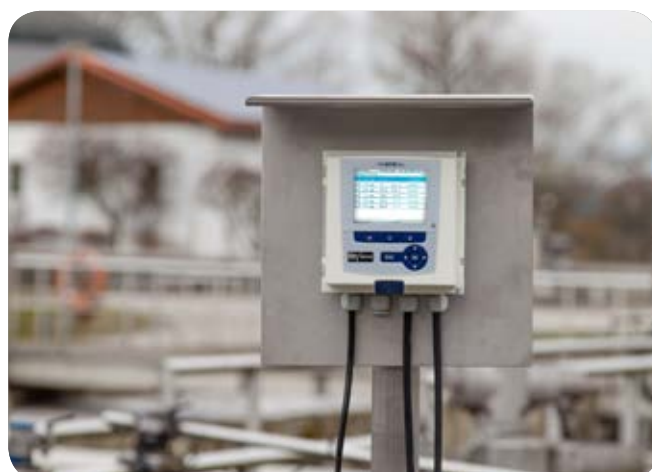
System 282/284 zur Optimierung der biologischen Reinigungsstufe
