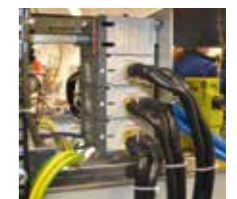
System-Hauptschalter PNOZ für Not-Aus-Kette
