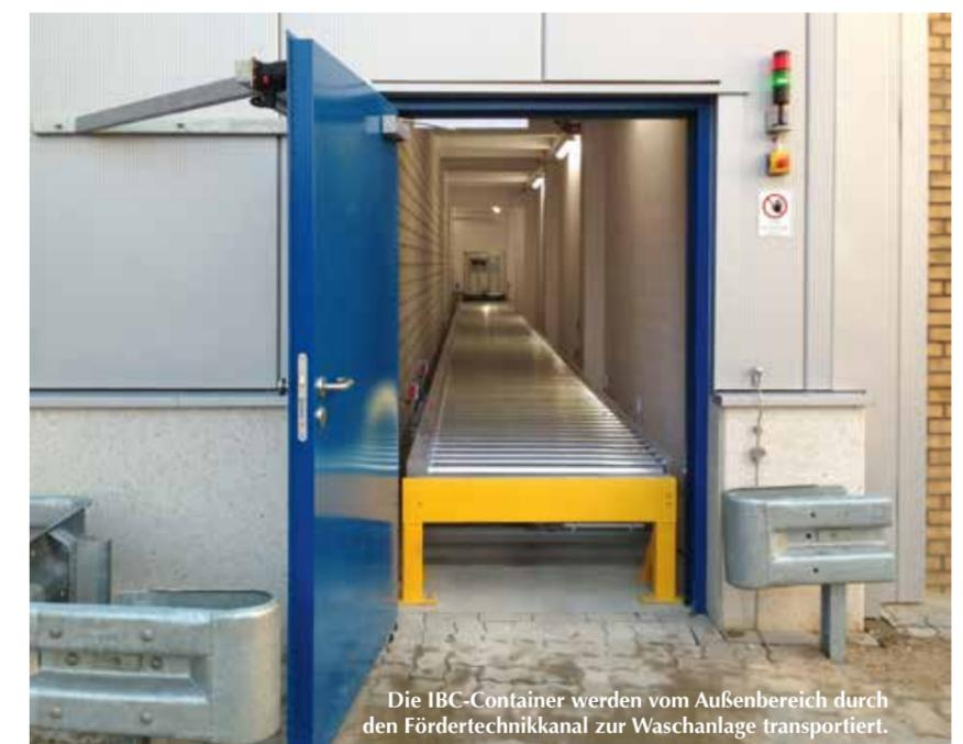
Die IBC-Container werden vom Außenbereich durch den Fördertechnikkanal zur Waschanlage transportiert.
