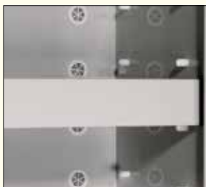
Be- und Entlüftung in jeder Schrankebene.
